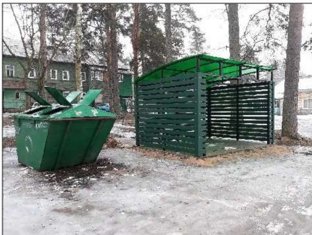
Фото 11 – пер. Солнечная д. 4, Контейнеры ТКО
