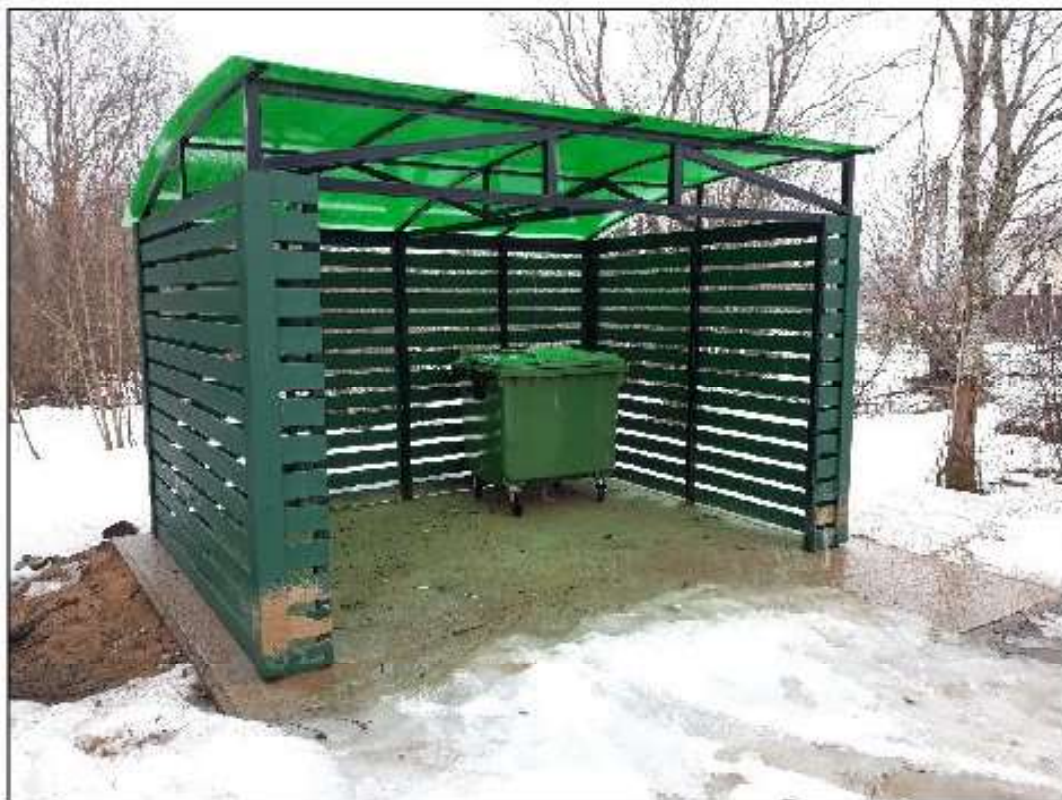
Фото 2 – ул. Морская-Радужная, Контейнеры ТКО
