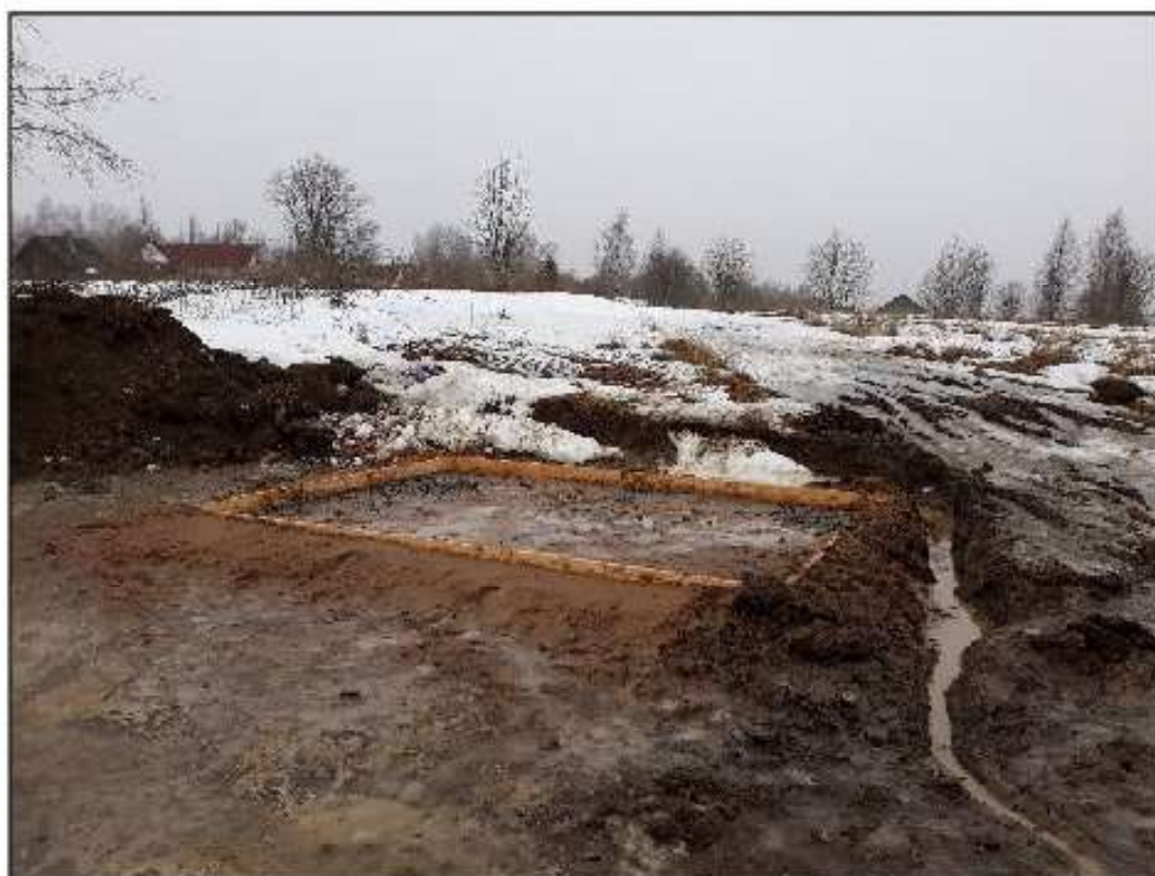
Фото 1 – ул. Криворучьевская, Контейнеры ТКО
